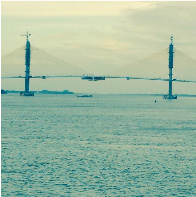
写真 25 ネアックルン橋(国道 1 号線)(ジェットロ撮影)
