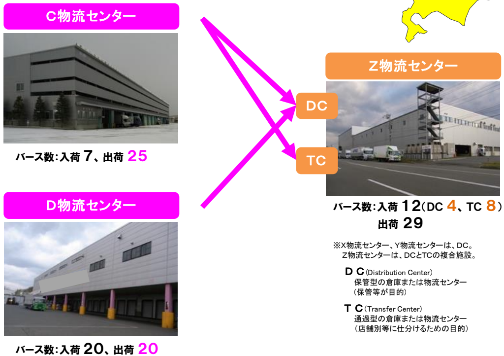
図 2-8 実態調査の調査対象施設(施設外観)
