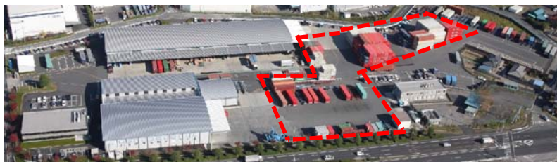
本社ターミナル内のコンテナバンプールを拡張施設(海上コンテナターミナル)に移設する(平成21年度～平成24年度の施設整備事業)
