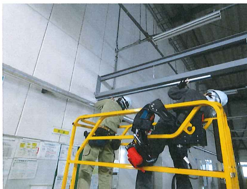
カーテンレールの取付
