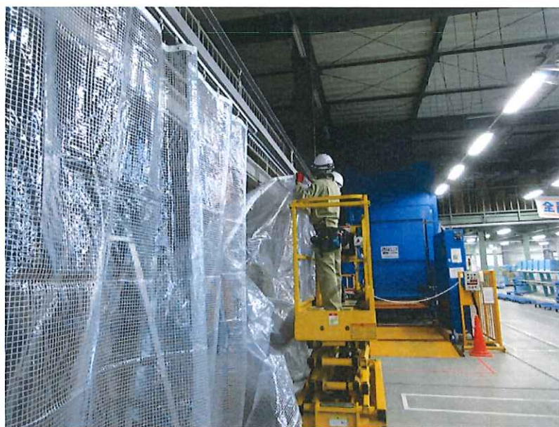
ビニールカーテン取付
