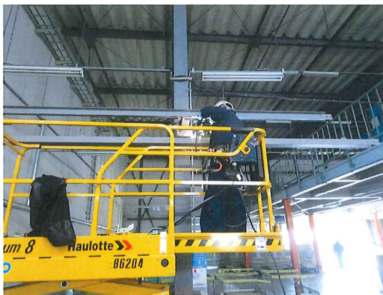
カーテン用鉄骨材取付
