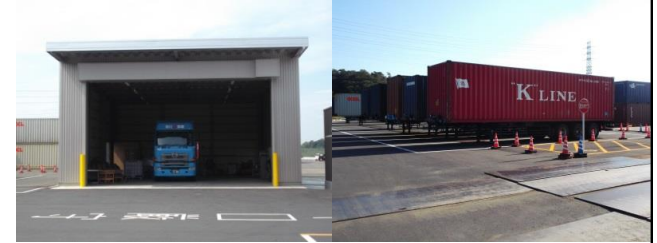
車両及びコンテナ整備場
