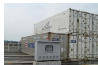
リーファーコンテナコンセント イメージ
