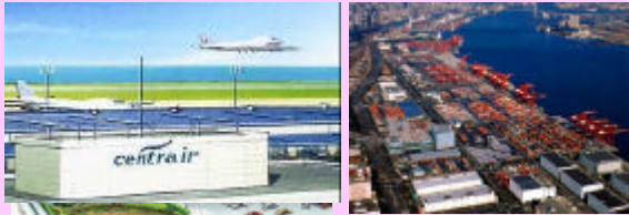
中部国際空港 H17.2開港
